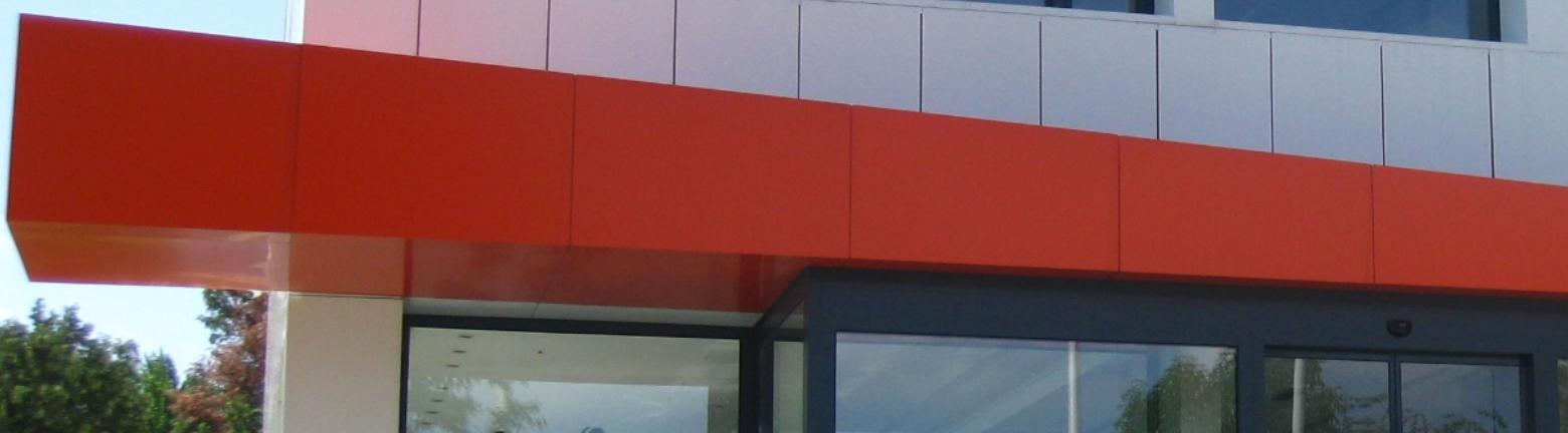
Ova grupa obuhvata sisteme aluminijumske podkonstrukcije sa oblogom koju čine ravno isečene ploče, koje se za podkonstrukciju vezuju vidnim ili skrivenim mehaničkim vezama i vezama hemijskih sredstava, odnosno lepljenja. Rešenja ovog tipa pokrivaju širok spektar fasadanih materijala, a sistemi su **RIVET, TACK, HIDE, STONE, ROCK i CONTINUAL**.
