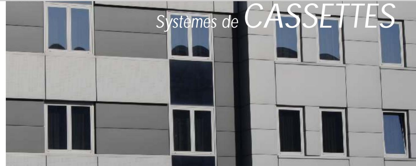
Ce groupe comprend 5 systèmes de sous-structures en aluminium où on utilise comme revêtement des cassettes, formées par le coupage, la flexion où à l'aide des rainures. Ces cassettes sont d'une profondeur variable et leur liaison avec sous-structure est le plus souvent complètement cachée. Les matériaux qui servent de revêtement sont plus plastiques et permettent un traitement additionnel. Les systèmes qui appartiennent a ce groupe sont: BOX, SLIDER, BOLT, GASKET, FIT.
