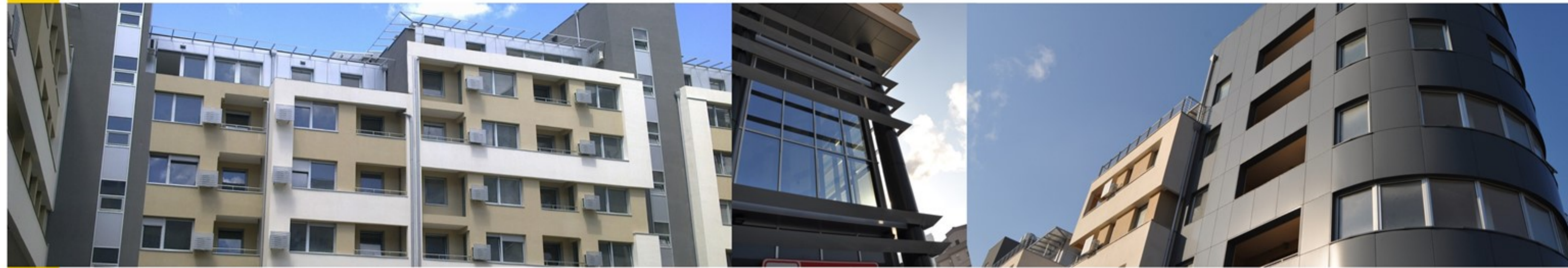
Tehnomarket VENT система подконструкции, алюминиевые композитные панели, окна LINEAL и Aluminik CS55 стеклянный фасад
