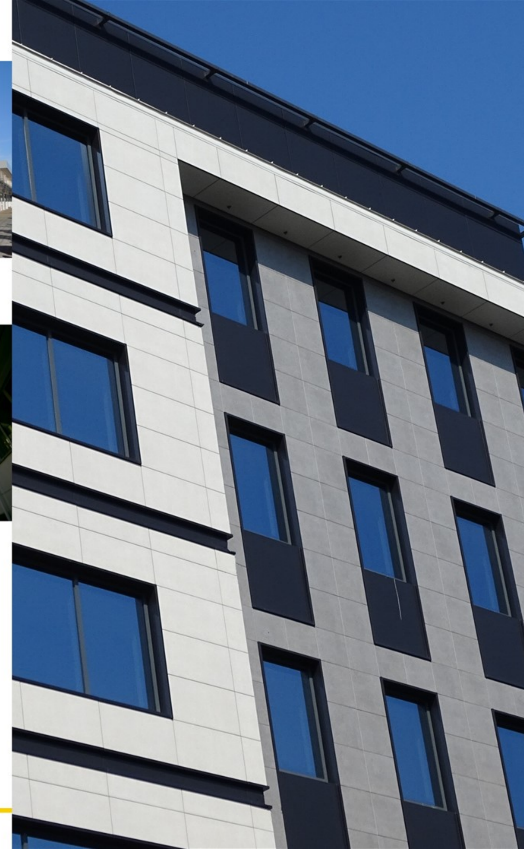
Tehnomarket система подконструкции, алюминиевые композитные панели, окна LINEAL и Aluminik CS55 стеклянный фасад
