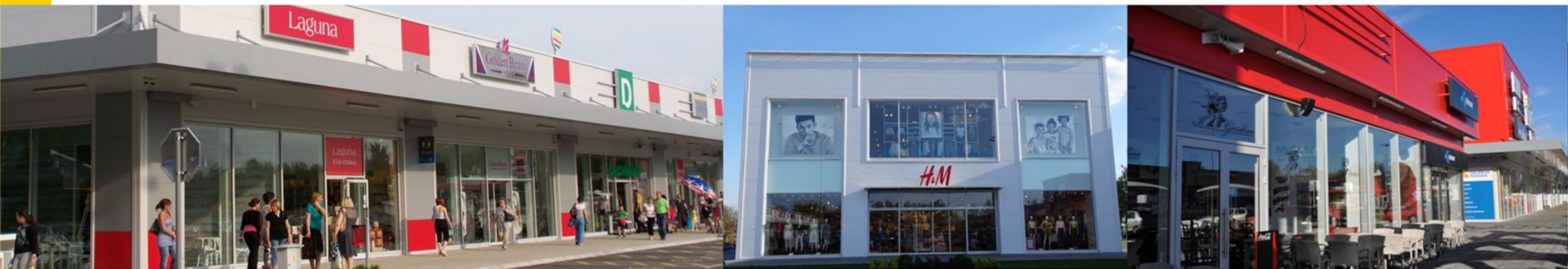
Tehnomarket VENT система подконструкции, алюминиевые композитные панели, окна LINEAL и Aluminik CS55 стеклянный фасад
